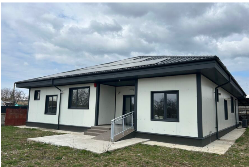
Centrul de zi nou construit – comuna Vâlcele, județul Olt
